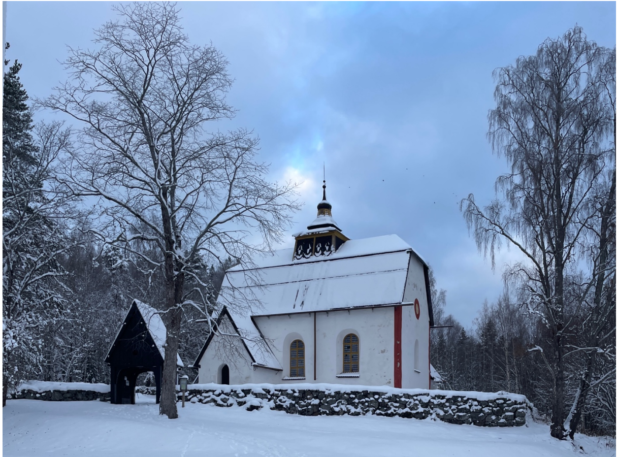
Figur 1 Ytterlännäs gamla kyrka från utsidan i vinterskrud
