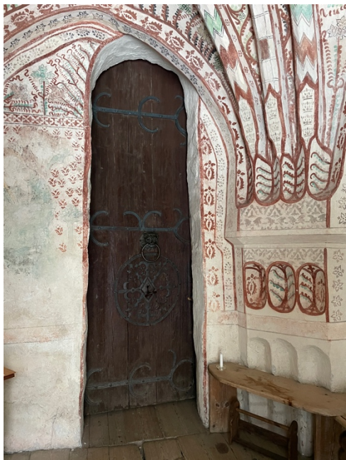
Figur 2 Porten mellan vapenhuset som leder in till längdhusets bakre del
